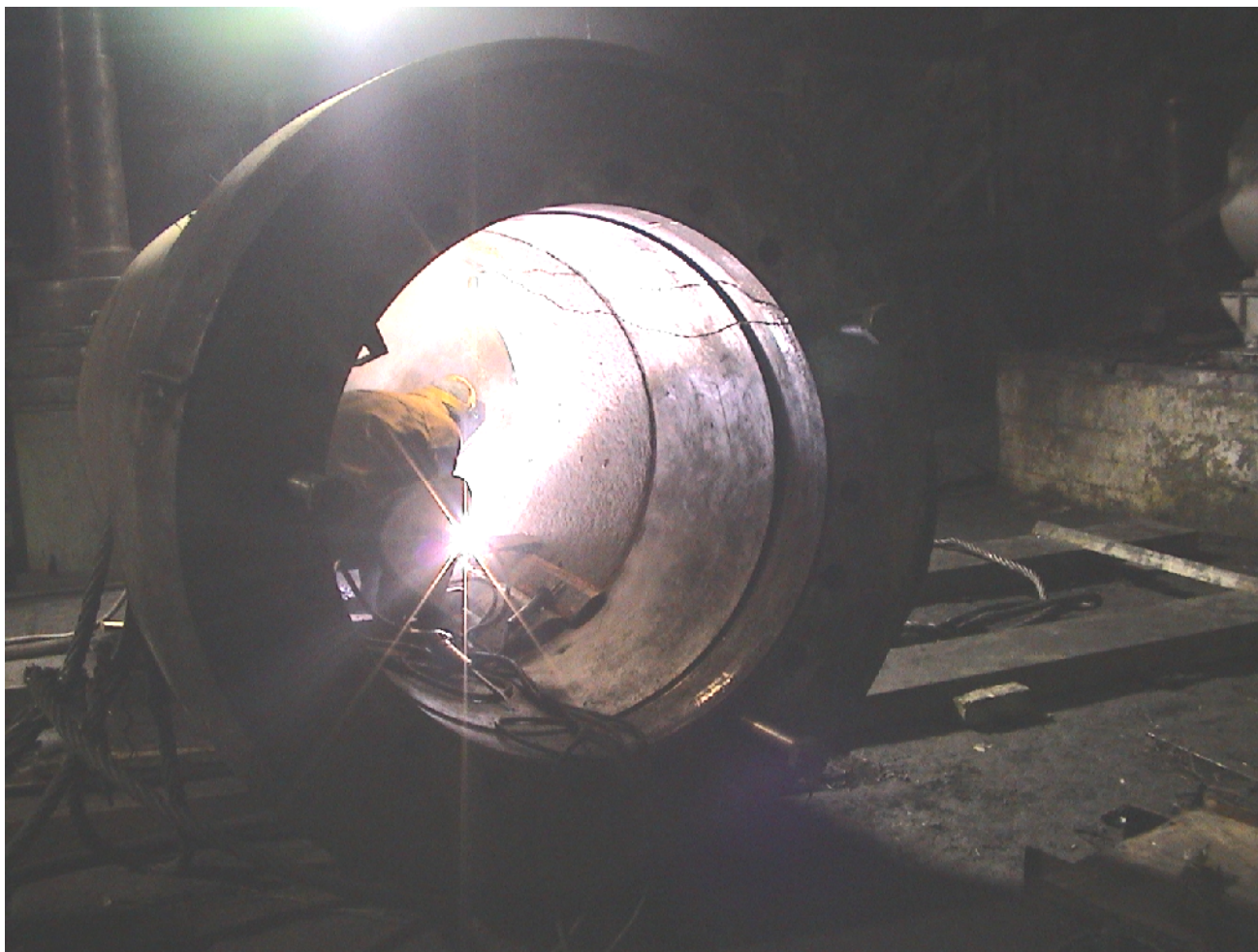
Рис. 4. Рабочий момент заварки трещины в галтели днища цилиндра силой 35 МН. Сварка проводится без предварительного подогрева, сварщик находится внутри цилиндра
