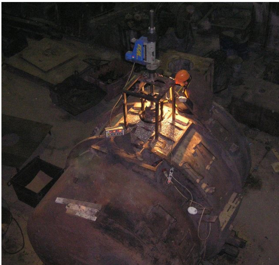
Рис.14. Рабочий момент обточки наплавленной цапфы ковша емкостью 90 тонн
