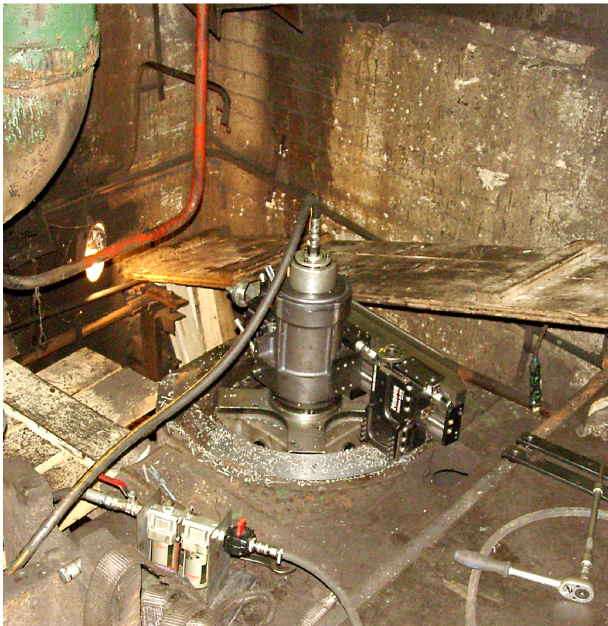
Рис. 5. Рабочий момент планировки контактной поверхности под гайку колонны на основании пресса силой 40 МН
