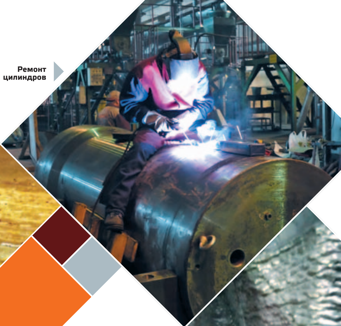
Плакировка разделанной трещины
